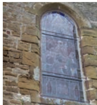
▲ Grille de protection des vitraux
