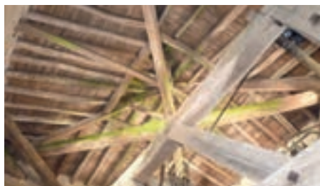
▲ Exemple de charpente ancienne vue depuis les combles
