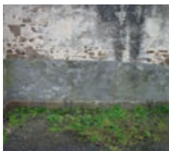
▲ Reprise des soubassements en ciment
