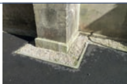
▲ Drainage périphérique extérieur
