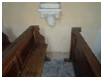
▲ Tranchée drainante intérieure
