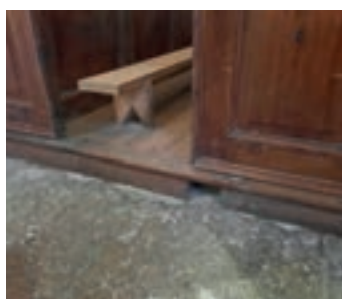
▲ Grille d'aération des plateformes
